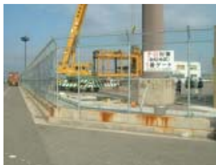
～フェンスの設置～
