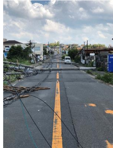
図Ⅱ-3 2018年台風第21号による電柱倒壊（泉南市） 出典：令和元年版防災白書
