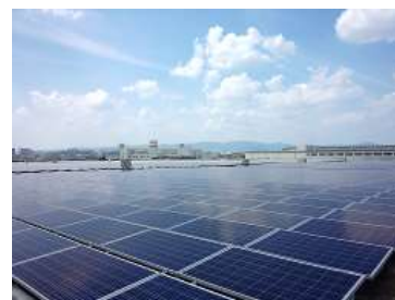
太陽光パネルの設置 (中央水みらいセンター)
