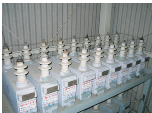
図一 9 PCB含有コンデンサの保管
