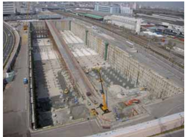
図 - 33 建設中の竜華水みらいセンター
