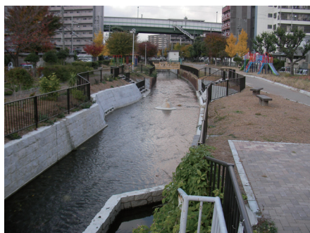
<長瀬川地区(東大阪市)での整備状況>
