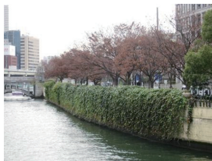
<護岸の壁面緑化>
