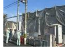
アスベスト解体現場パトロール
