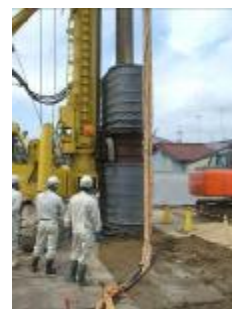
土壌汚染の除去措置の実施状況
