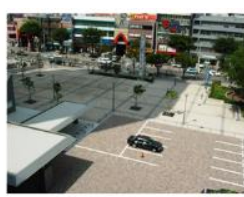
透水性・保水性舗装
