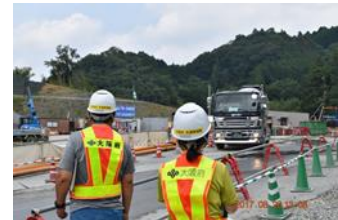
流入車規制の立入検査
