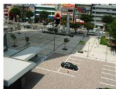
透水性・保水性舗装
