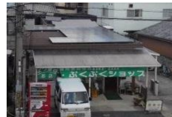
障がい者作業所に設置
