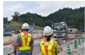
流入車規制の立入検査
