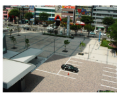
透水性・保水性舗装
