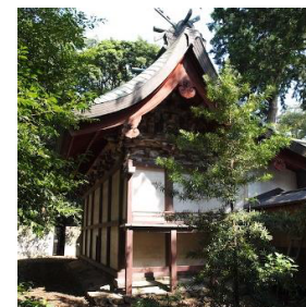
有形文化財（建造物）
