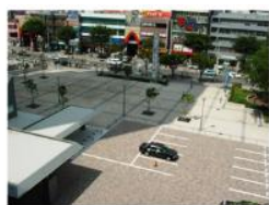
透水性・保水性舗装
