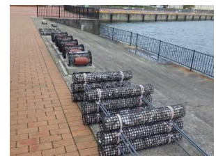
環境改善モデル設備の設置
