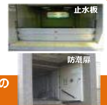
地下鉄出入口の浸水対策
