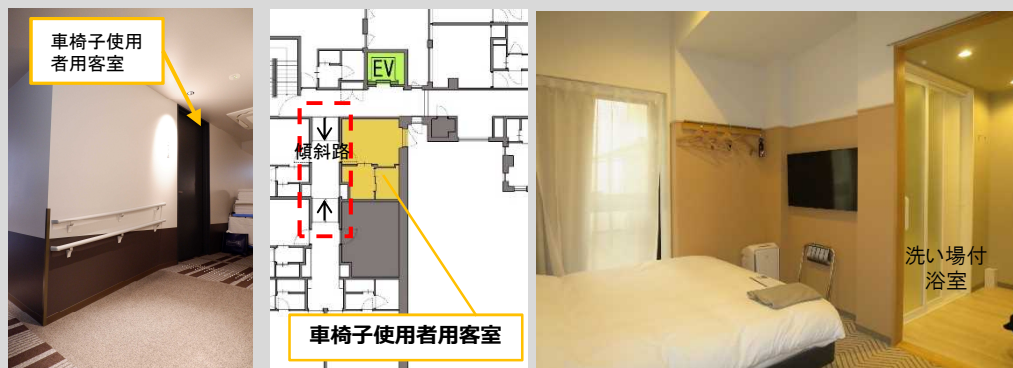
共用廊下のスロープ設置により段差解消（車椅子使用者用客室内のフラット化）
