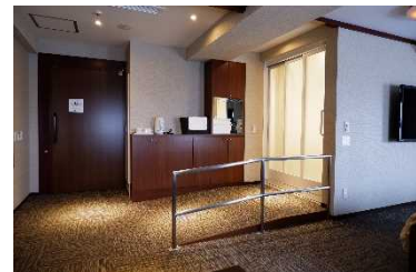
●客室内の便所・浴室又はシャワー室手前に傾斜路を設置する
