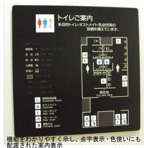
○便所の触知図案内板の設置例
