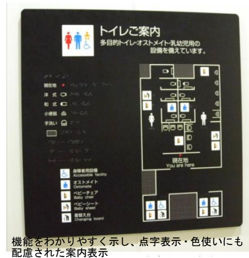
○便所の触知図案内板の設置例
