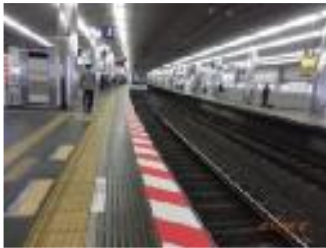
ホーム端の注意喚起シート
