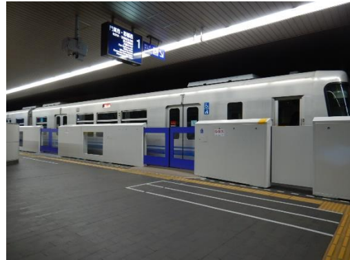
大阪高速鉄道(株) 千里中央駅
