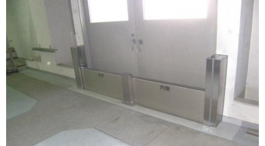
建物の耐水化(止水板の設置)
