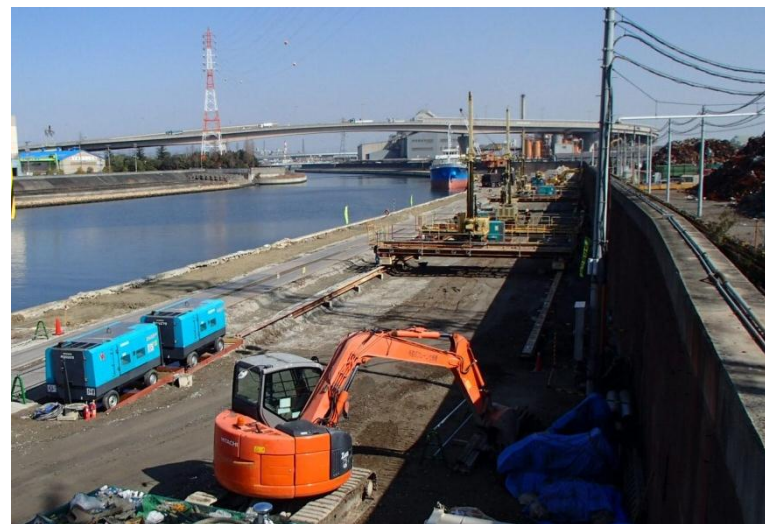
施工中(地盤改良工)
