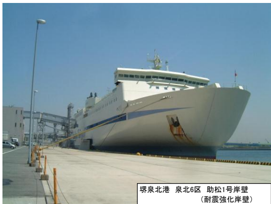
【耐震強化岸壁の整備】
