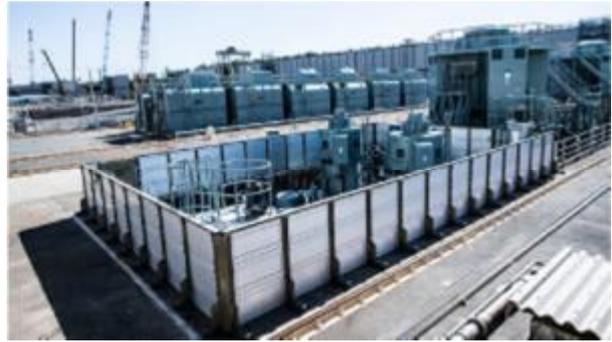
図-3.2 屋外に設置された電気設備の高所移設（中部電力HPより）
