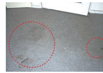
飲み物等をこぼしたことによるカーペットのシミ 手入れ不足等で生じたもの⇒ 借主負担
