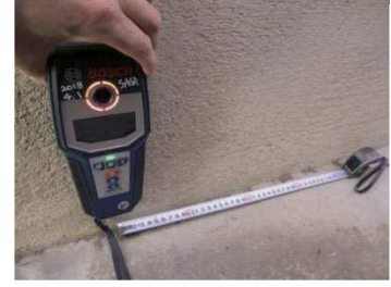
鉄筋配筋の確認（鉄筋探査機）
