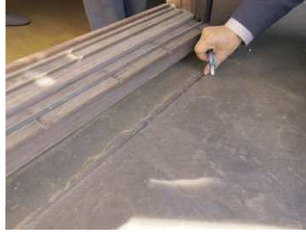
バルコニー防水の確認
