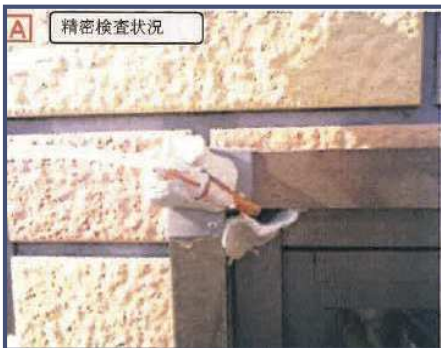
④見切材とサッシの取合
