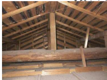
小屋組の確認
