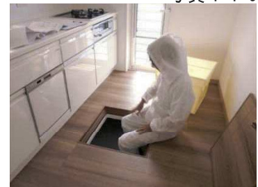
床下進入による確認
