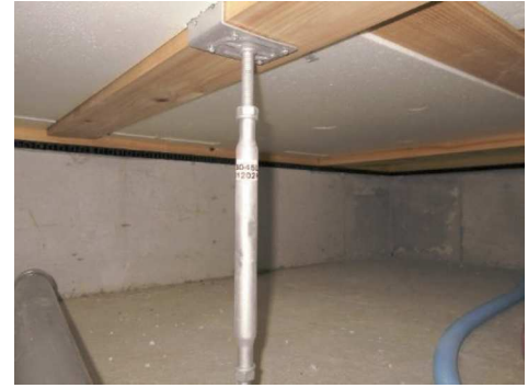
床下の状況 鋼製束等による床の支持状況は良好であり、不具合は無かった。
