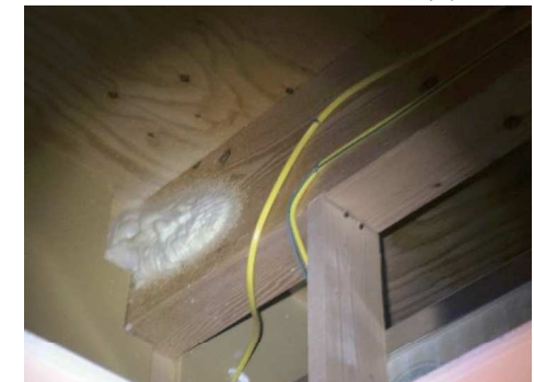
小屋組の確認 外気と接する金物部分は温度が下がりがり結露する恐れがあるが、金物部分に吹付断熱材を施工し対処している。
