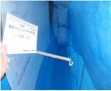
5 ケイカル板解体前 養生完了
