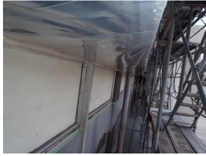
図表 1-11 軒裏工事作業後の飛散防止ビニル養生状況
