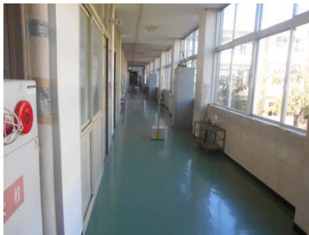
校舎内 2階廊下
