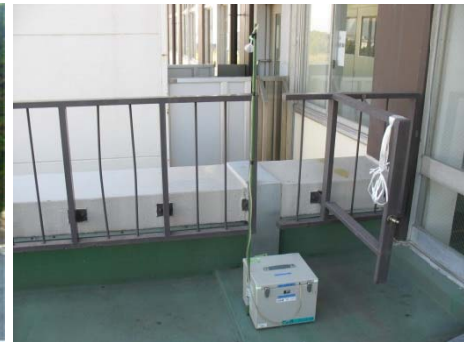
校舎外 (4階渡り廊下)
