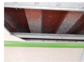
測定点2-1付近 ボード撤去後
