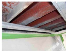
測定点2-3付近 ボード撤去後
