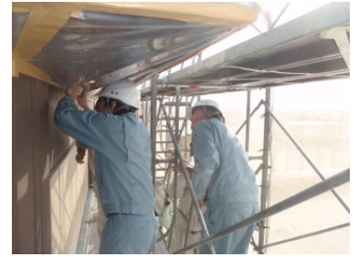
3 堺市環境指導課 養生及び石綿確認
