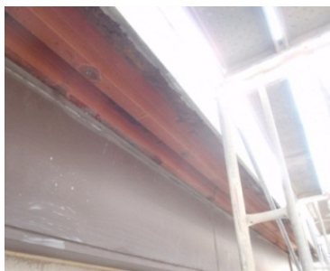
11 完了確認(塔屋西面X10)
