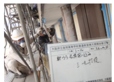
9 シーリング打設(3階X14~15Y9)
