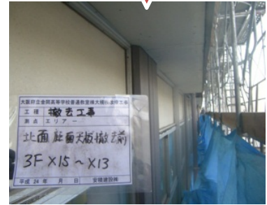
3 ケイカル板解体前 養生状況
