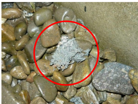
②中庭 足場周りに散乱
