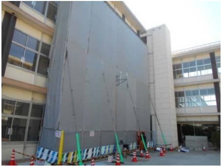
養生シート設置状況
