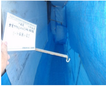
5 ケイカル板解体前 養生完了
