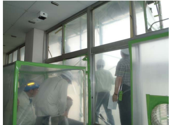
廊下側（北側） 前室～作業床
