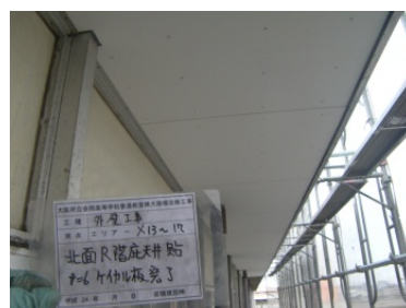
8 ケイカル板設置完了(R階X13~17Y9)
