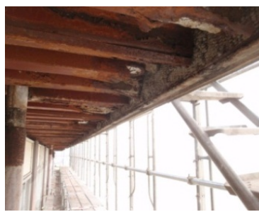
10 完了確認(南面3階8~4)
