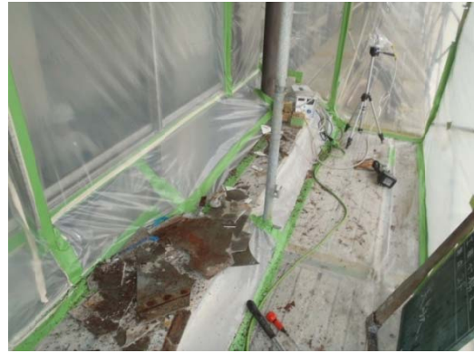
廊下側（北側）アスベスト撤去後濃度測定状況
