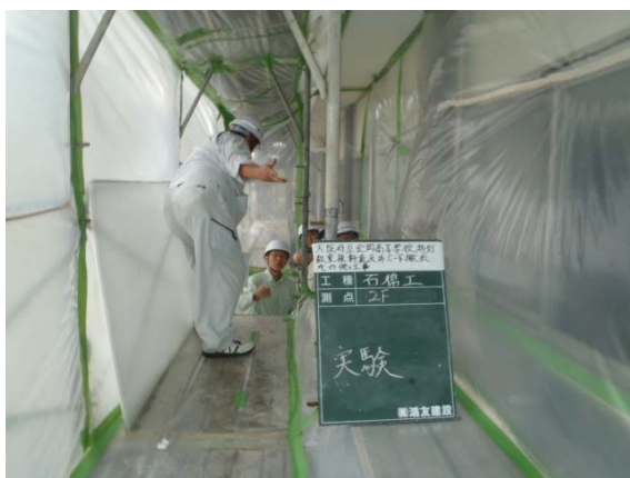
廊下側（北側） 作業床養生内
