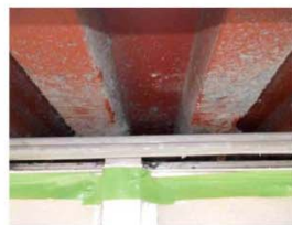
測定点2-3付近 ボード撤去後
