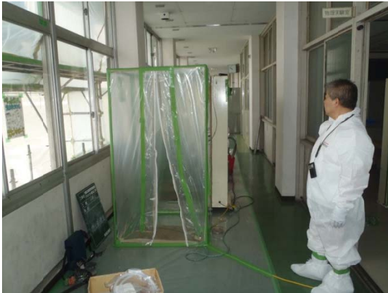
廊下側（北側） 脱衣室
