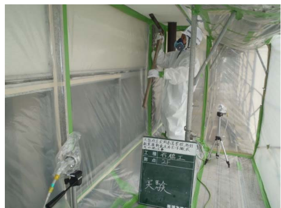
廊下側（北側） 庇裏撤去状況
