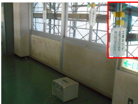
校舎内2階放出点直近窓付近
