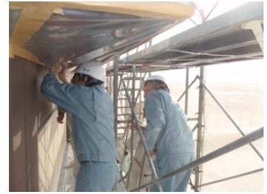
3 堺市環境指導課 養生及び石綿確認
