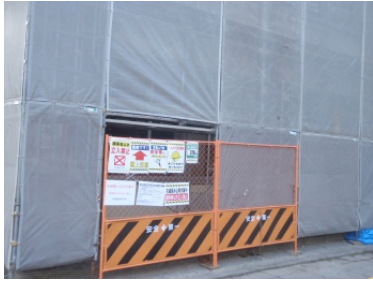
1 関係者以外立入禁止 看板設置
