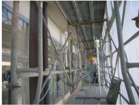
養生シート内部の状況
