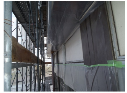
図表 1-11 軒裏工事作業後の飛散防止ビニル養生状況
