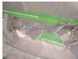
測定点2-3付近 ボード付着物
