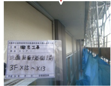
3 ケイカル板解体前 養生状況
