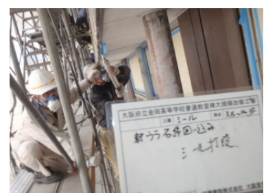
9 シーリング打設(3階X14~15Y9)
