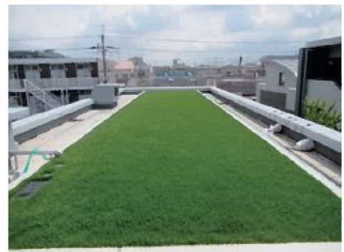
屋上部の芝生
