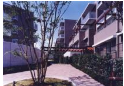
アプローチ広場から住棟を見る(撮影:斎部功)
