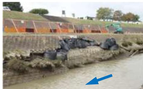
写真 2.1-6 護岸の崩壊
