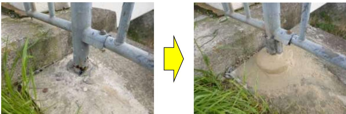
写真 4.5-3 直営作業による柵補修（支柱腐食箇所補修）
