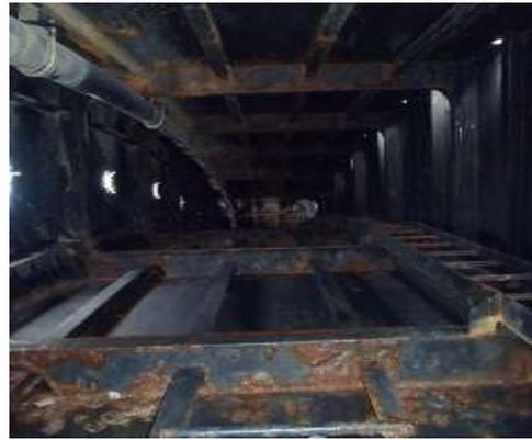
水門扉体内面の腐食状況
