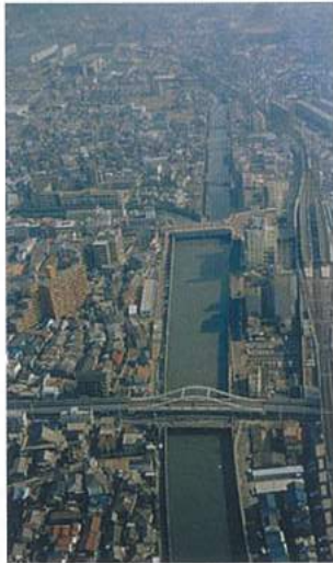
改修後 (平成12年)
