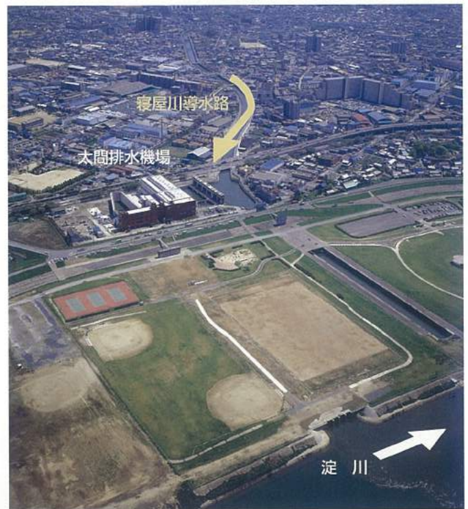
太間排水機場
