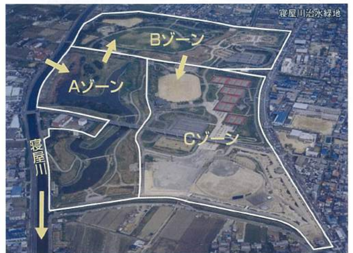
平成11年8月 寝屋川治水緑地 貯留状況
