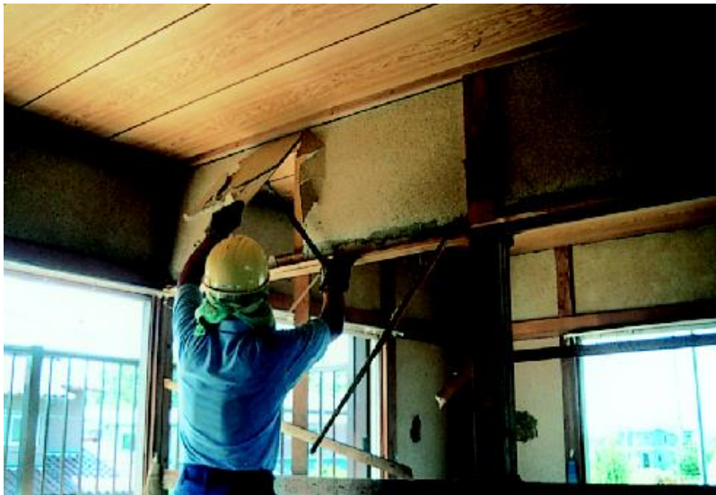
内装材の取り外し
