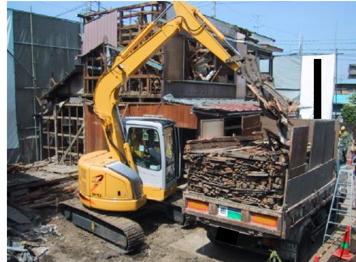
建設発生木材の搬出
