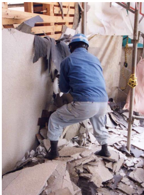
外装材の取り壊し
