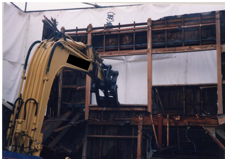
上部構造部分の取り壊し
