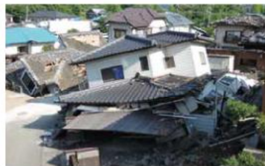
地震による被害例（熊本地震）
