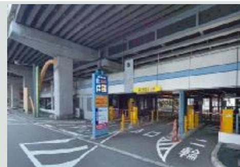
【江坂南駐車場】
