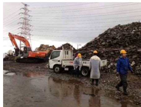
【矢護川災害廃棄物仮置き場での作業の様子】
