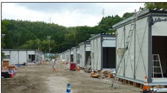
〔仮設住宅建設現場〕
