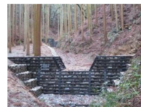
流木の被害を防ぐ治山ダム
