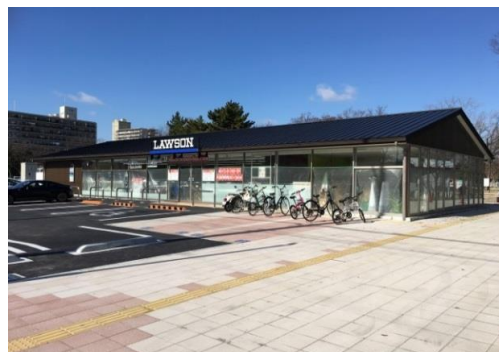
民間事業者による府営公園のにぎわい施設の設置イメージ コンビニエンスストア（久宝寺緑地） 【写真：大阪府】
