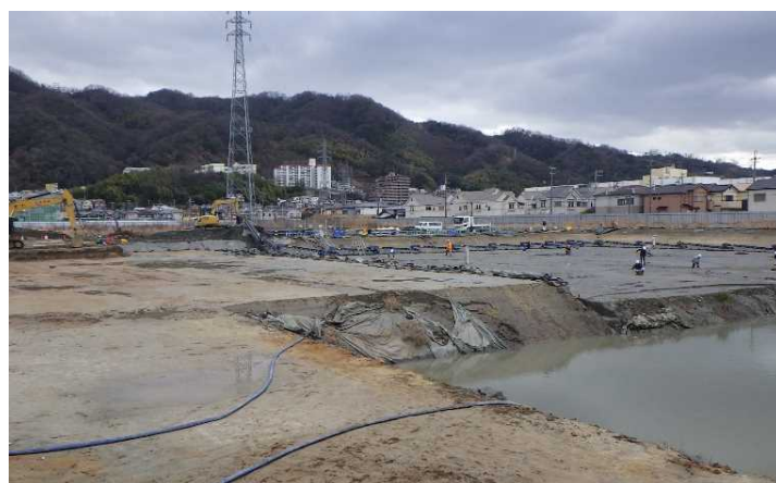
①-2 文化財掘削状況(令和2年2月17日時点)
