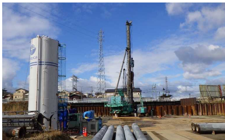
②-1 杭打状況（令和2年2月3日時点）
