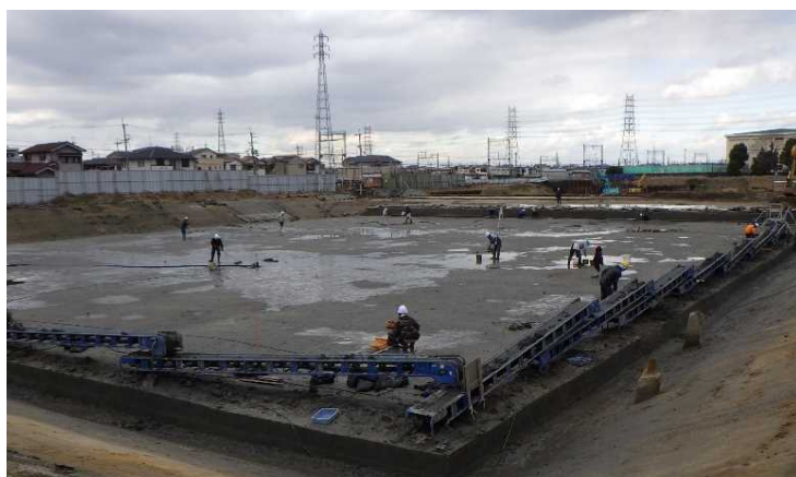
①-1 文化財掘削状況(令和2年2月17日時点) (計画掘削深さ 4.7mの内、2.3mまでの掘削完了。)
