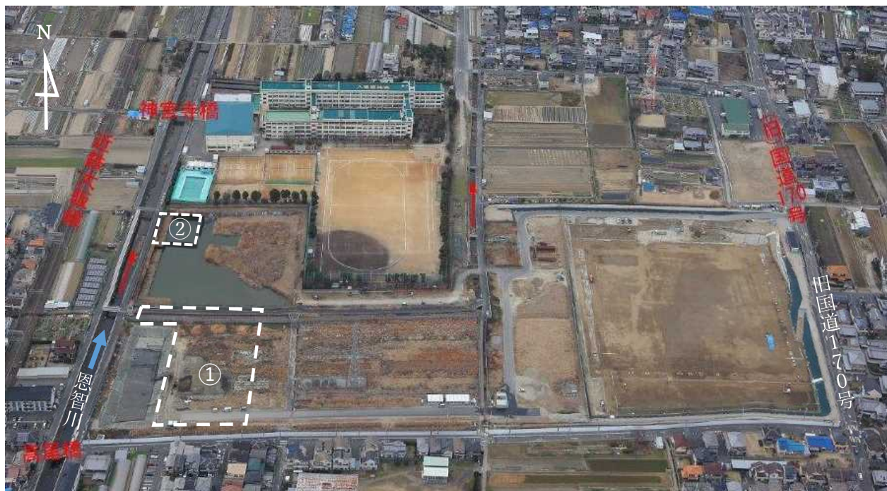
恩智川（法善寺）多目的遊水地全景写真（H31.1）
