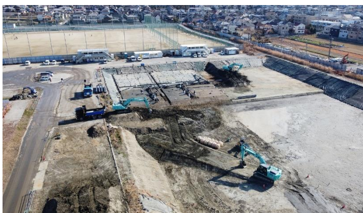
① 文化財掘削状況(令和5年1月時点)
