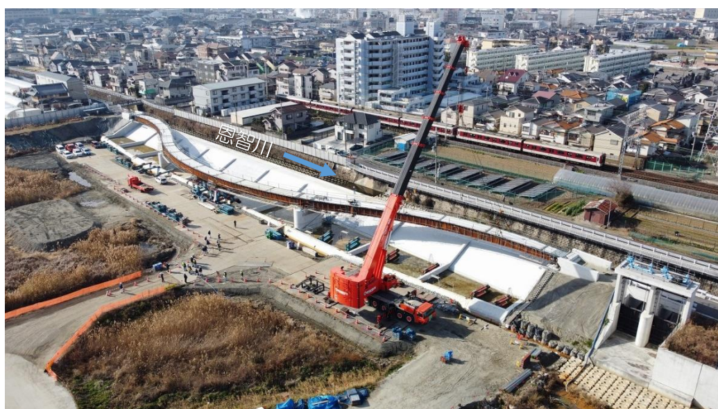
②-2 桁架設状況（令和5年1月時点）
