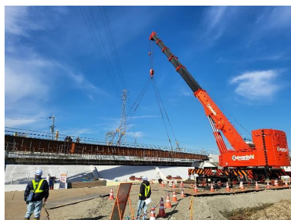
②-1 桁架設状況(令和5年1月時点)
