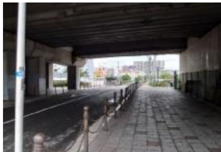
国道高架下の暗い歩道
