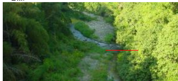
図 2.5.4 2-51 検討対象箇所状況
