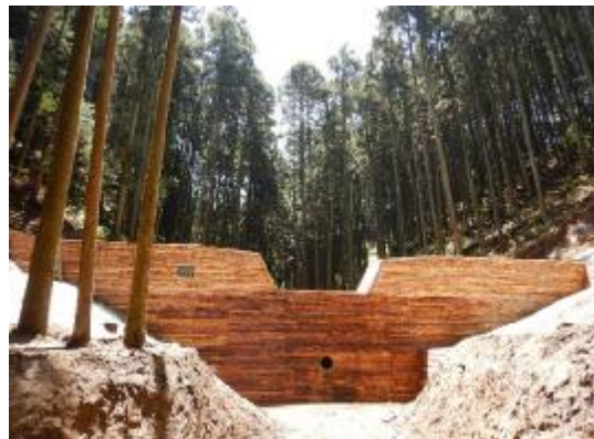
治山ダムの整備
