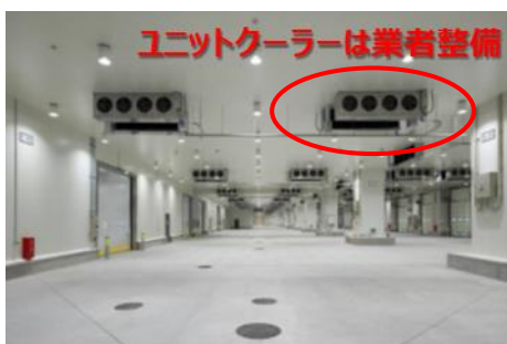
水産卸売場棟施設内状況
