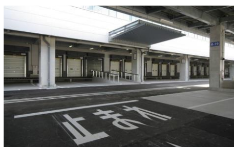
水産仲卸売場棟高床式バース
