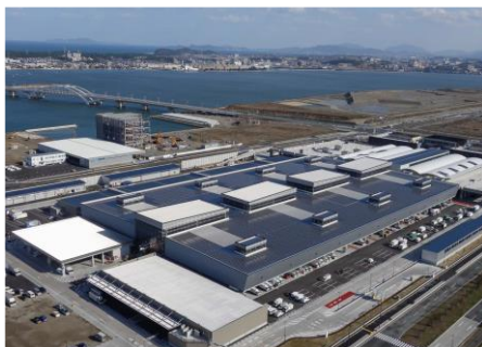
屋上太陽光発電
