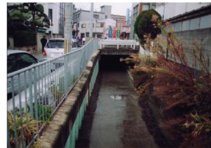
④ 上流は暗渠(上流を見る)
