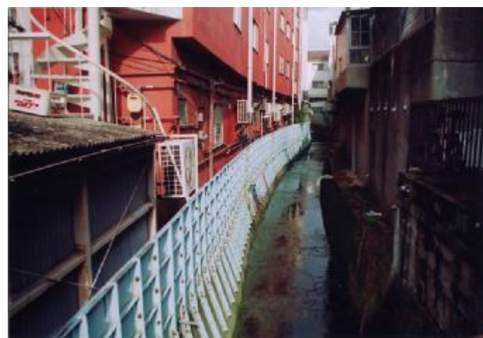
③ 右岸…鋼製護岸(上流を見る)
