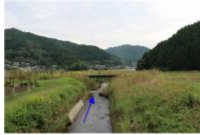
写真② 田尻川（ うたかき 歌垣橋付近）
