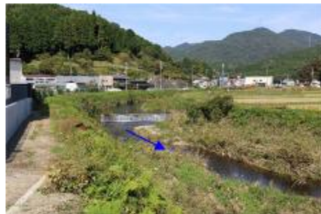
写真③ 山辺川 (柳橋 やなぎ 付近)
