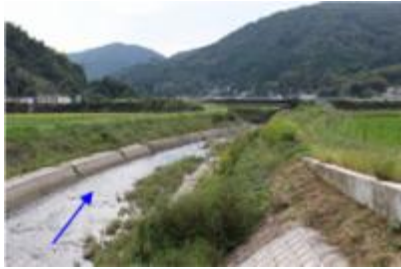
写真① 田尻川（ ふじき 藤木橋付近）
