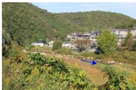
写真① 下流部 (大阪府管理区間下流端付近)
