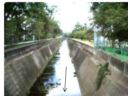
改修箇所写真(水路橋上流)
