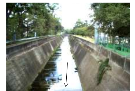
改修箇所写真(水路橋上流)
