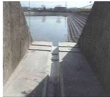
【治水容量の確保】 余水吐を溝状に切り下げることで、 常時の水位低下を行う。
