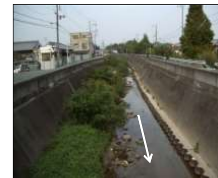
豊南橋から上流を見る
