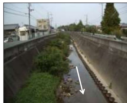
豊南橋から上流を見る
