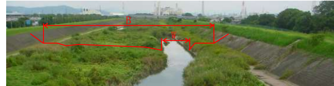
区間B：宮島橋(上流側)
