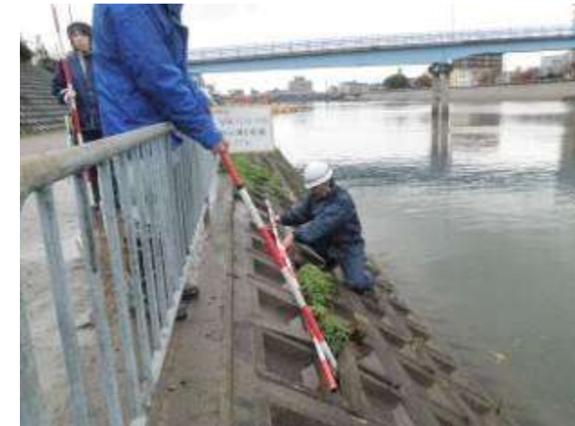
河川管理施設の点検の状況
