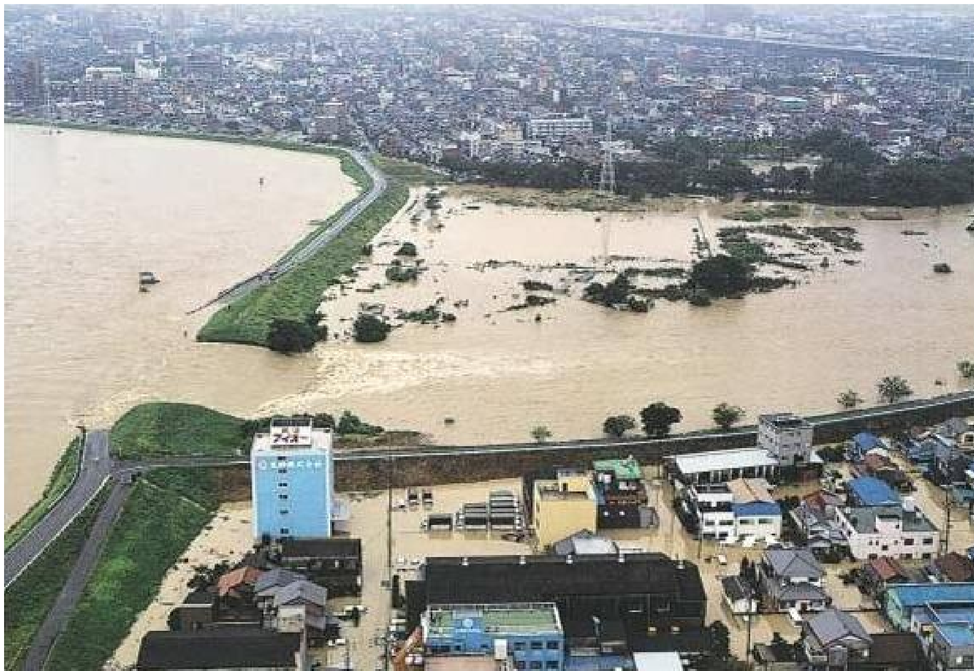
平成12年9月 東海豪雨による堤防決壊と浸水被害状況（愛知県名古屋市）
