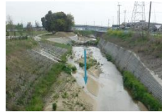
河川改修（穂谷川）
