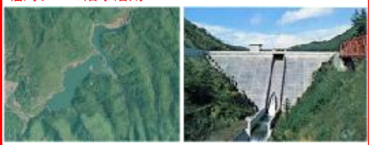
堀河ダムの治水活用
