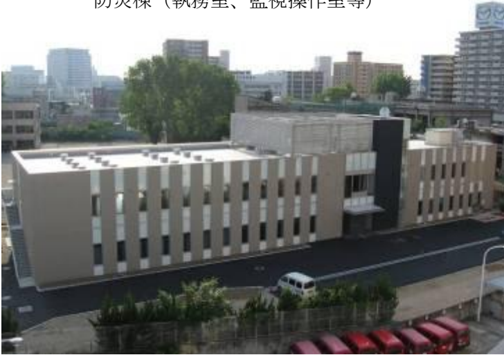
防災棟（執務室、監視操作室等）
